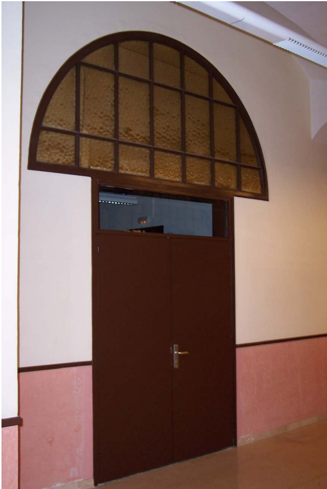
Nou magatzem de manteniment
